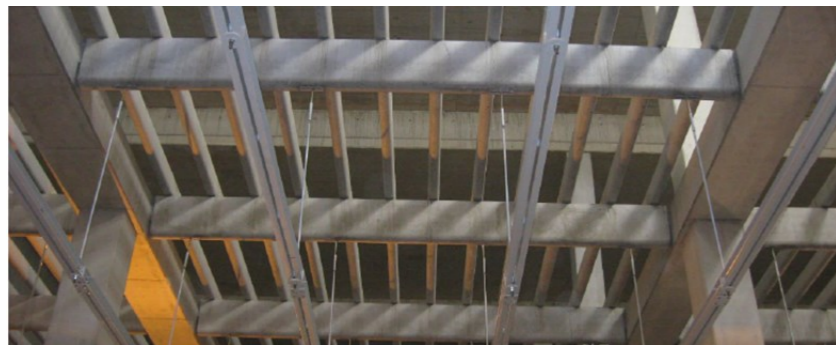
Attuale solaio sala rack da smantellare
